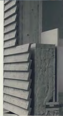
Schnitt durch eine Wand mit Schaafwoll-dämmung
